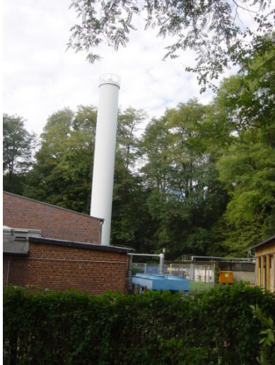
Abb. 3: Kamin des Kesselhauses
